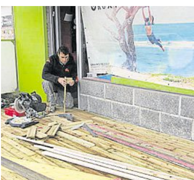
La terrasse Atao aman en cours de construction.
